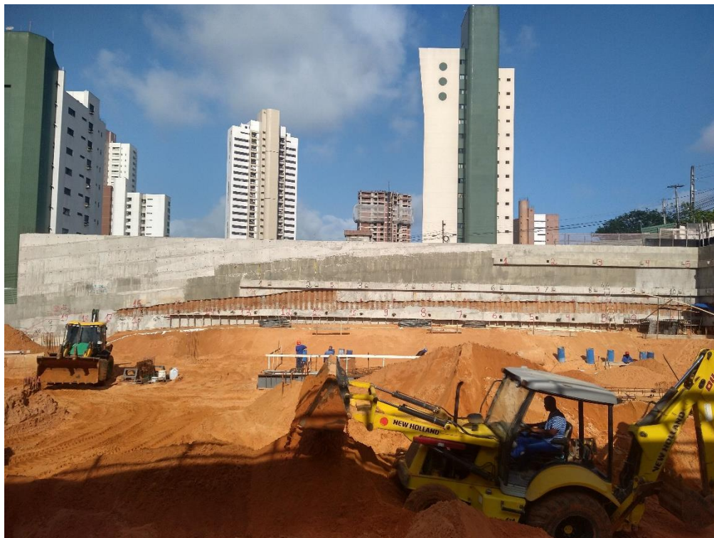
Figura 4. Tirantes da segunda linha concluídos e início da escavação da terceira linha.
