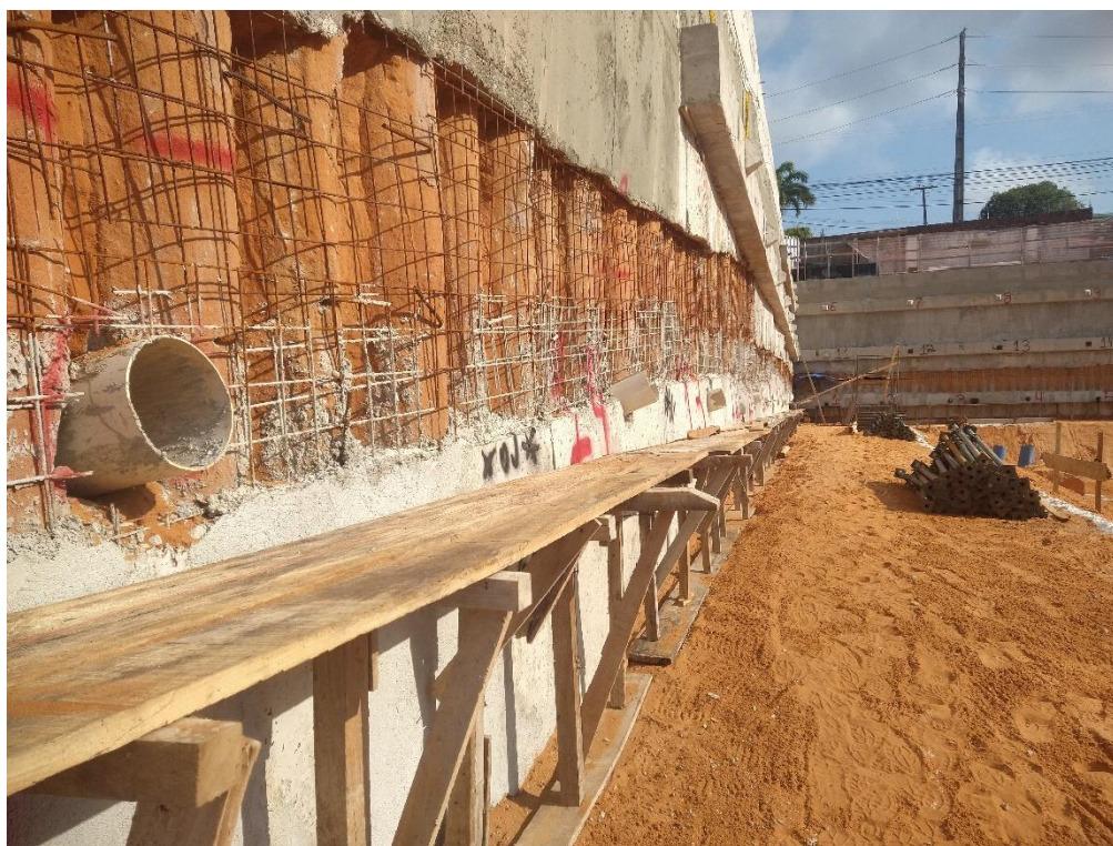
Figura 5. Furo para instalação de tirante na terceira linha.
