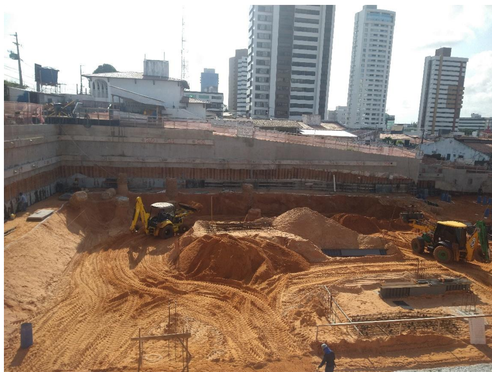
Figura 2. Movimentação de terra e última berma restante.
