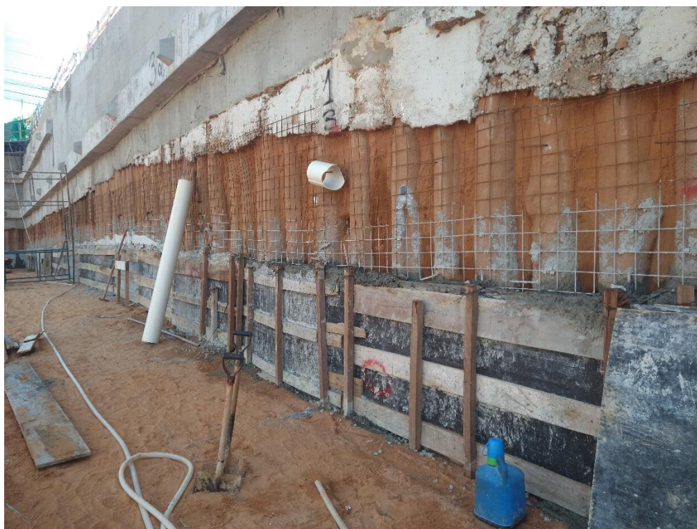
Figura 6. Revestimento de concreto com tela metálica.
