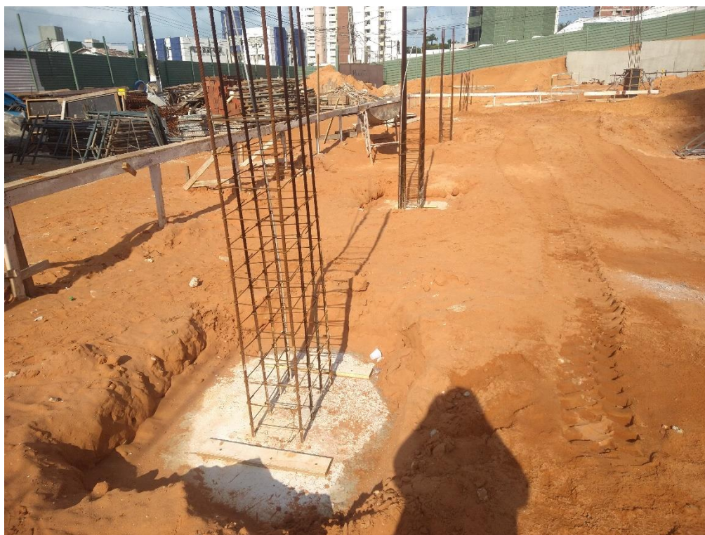
Figura 7. Blocos de coroamento das estacas de fundação.
