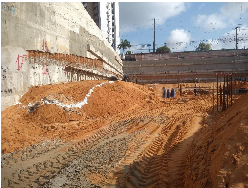
Figura 3. Última berma da contenção.
