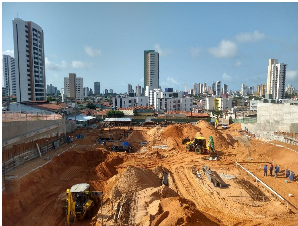
Figura 1. Visão geral da obra.
